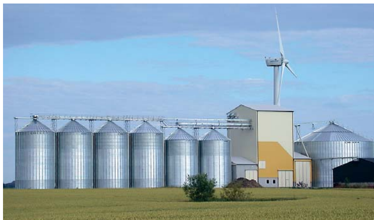
Skånska Lantmännens Lokalförening i Trolleås, Eslöv. Färdigställd 2002 med en torkkapacitet på 33 ton/tim.
